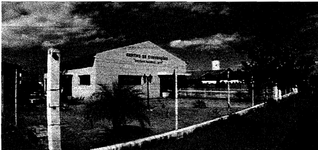
Imagem 25 – Centro de convenções
