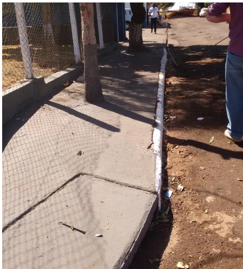
Trecho da Rua Cristiano Kraus entre os quarteirões da Rua Prefeito José Alferes com Rua projetada.
