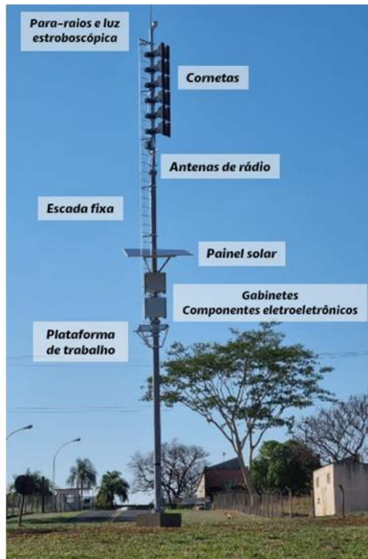
Figura 6 - Torre de sirene típica
