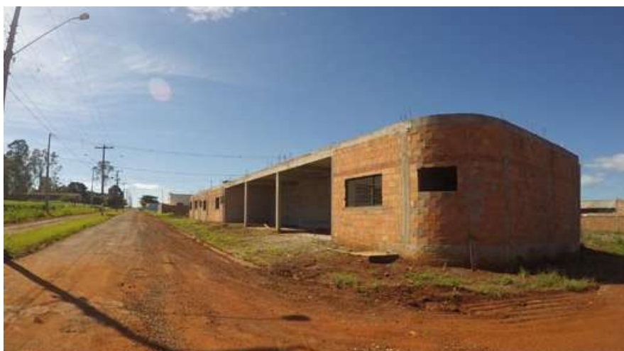
Imagem 38 – Hotel em construção
