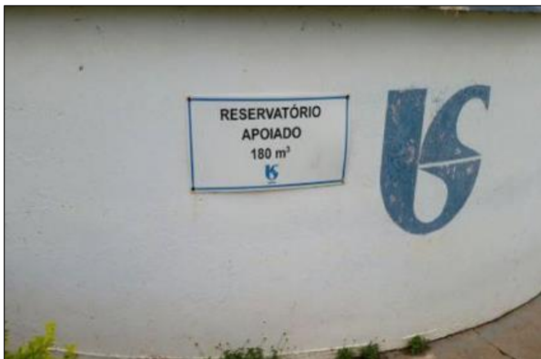
Figura L – Reservatório apoiado de concreto armado.
