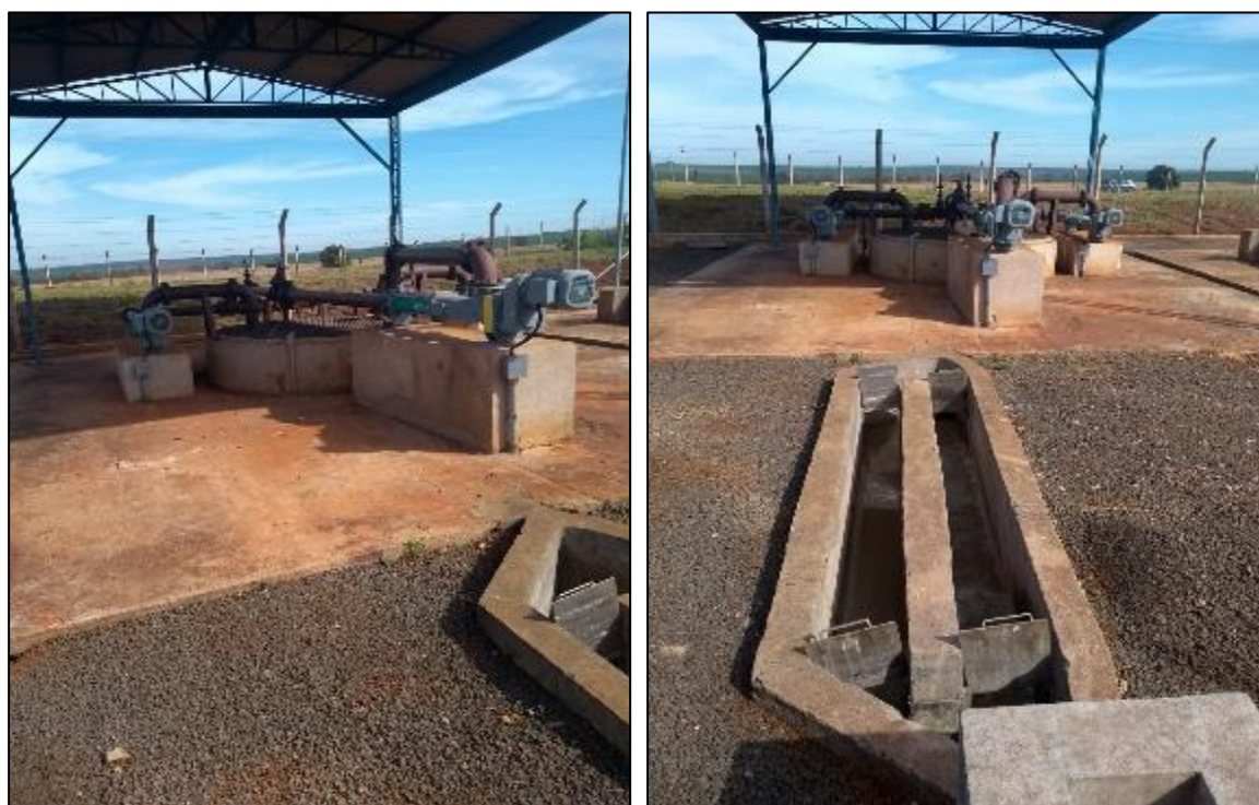
Figura LXXX – Estrutura de tratamento preliminar e conjunto elevatório
