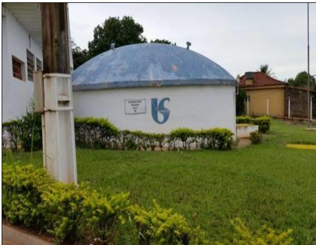
Figura XLIX – Reservatório apoiado de concreto armado.
