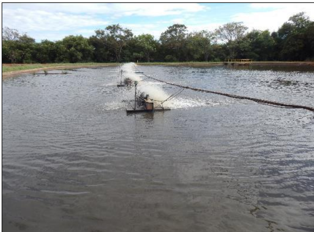
Figura LXXIV – Instalação de aeradores para melhora da eficiência do tratamento
