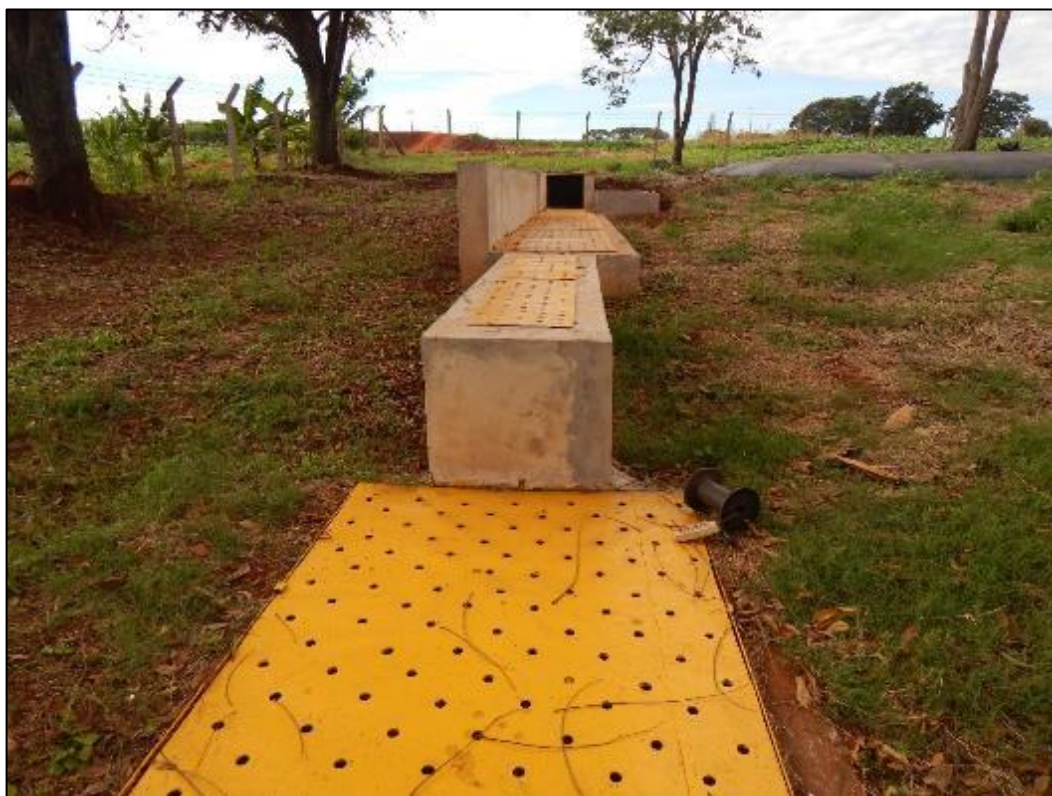
Figura LXXVII – Tratamento preliminar – gradeamento e caixa de areia
