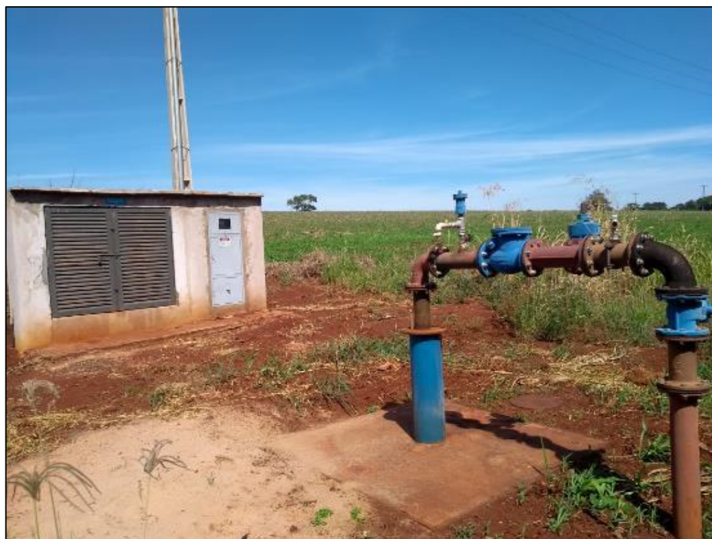
Figura XLII – Detalhe do Poço P3 com macromedidor de vazão
