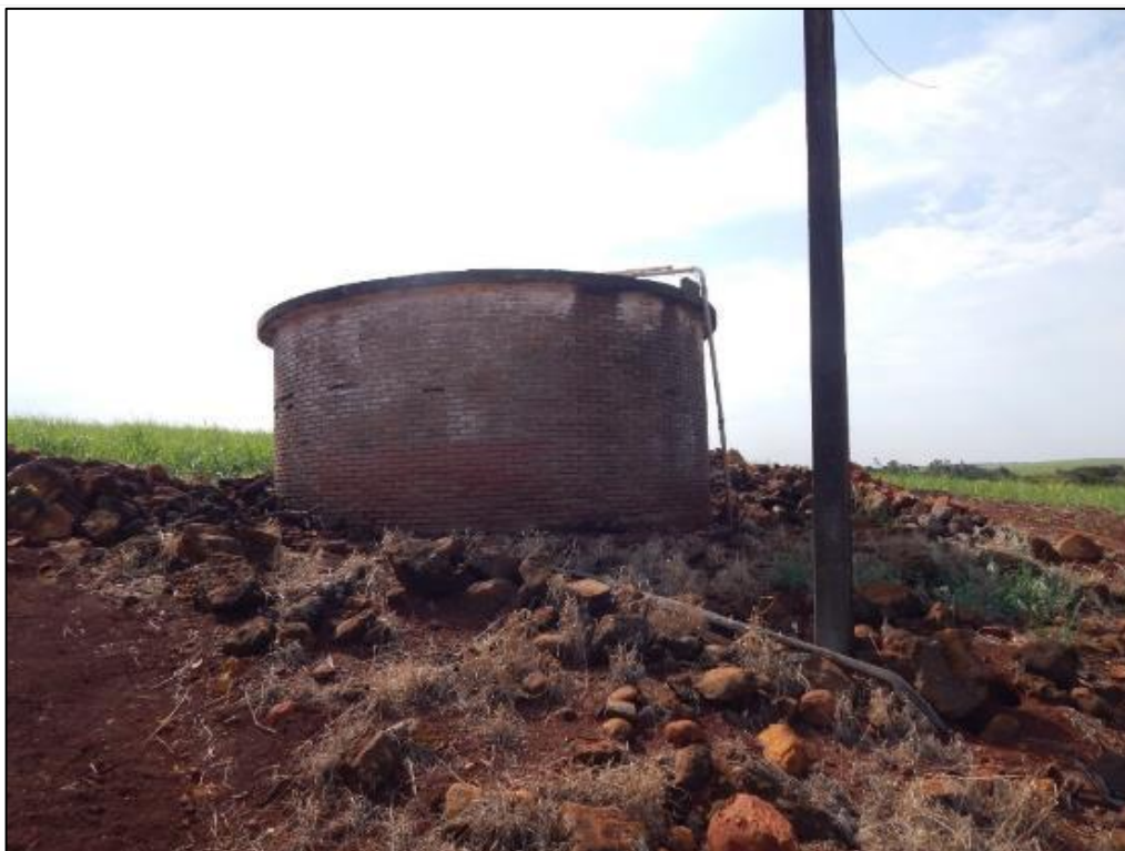
Figura LX – Reservatório em alvenaria e poço profundo
