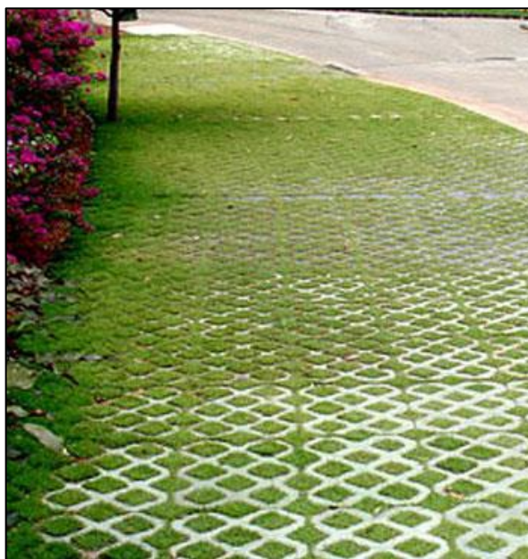
Figura CXXIX – Exemplo de aplicação de pavimento poroso (Concregrama)
