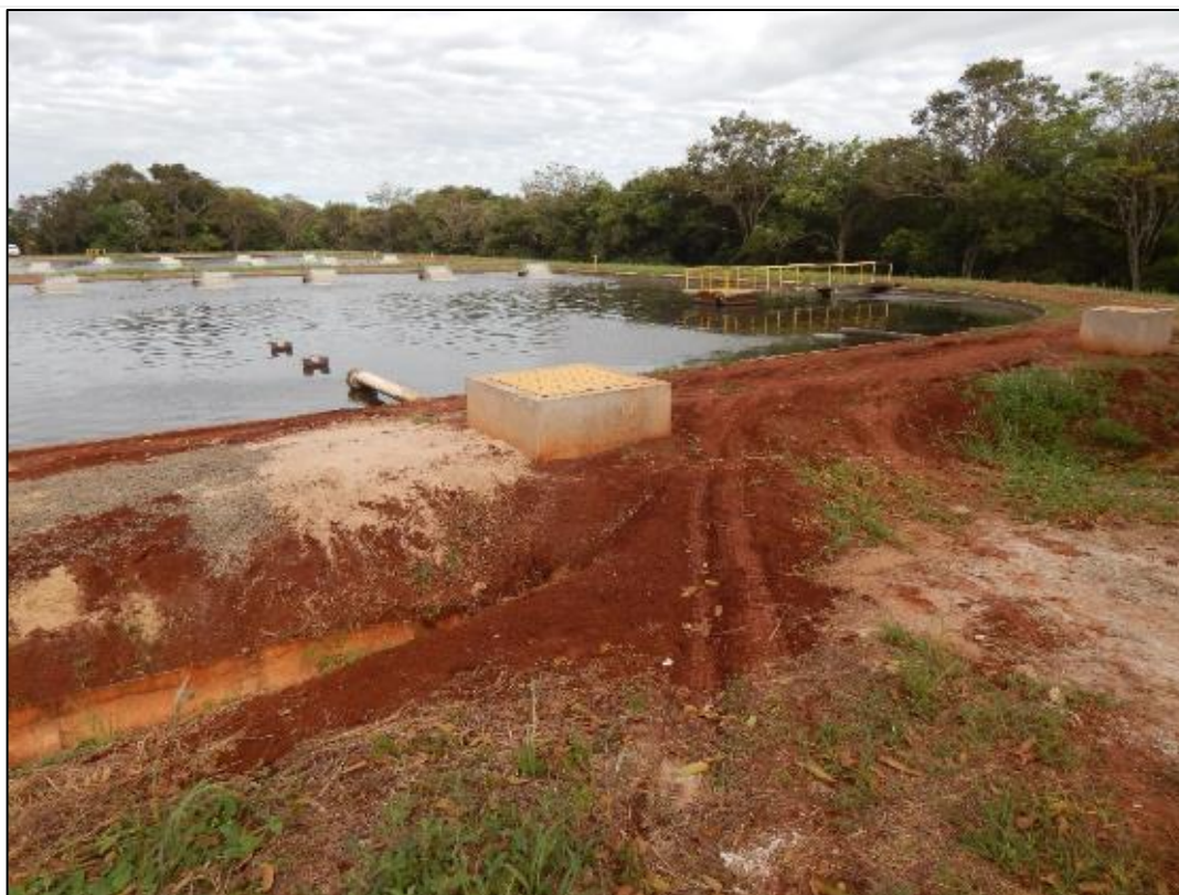
Figura LXXII – Vista geral das lagoas de tratamento de esgoto
