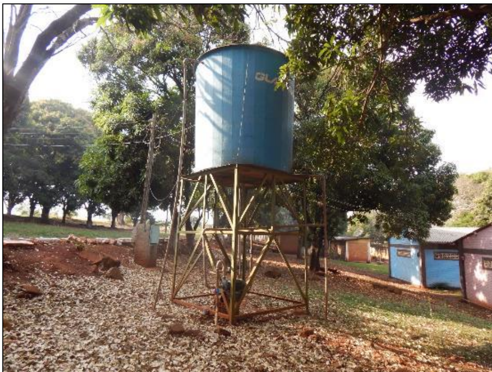
Figura LXII – Caixas d'água auxiliares no sistema de reservação próximo a residências
