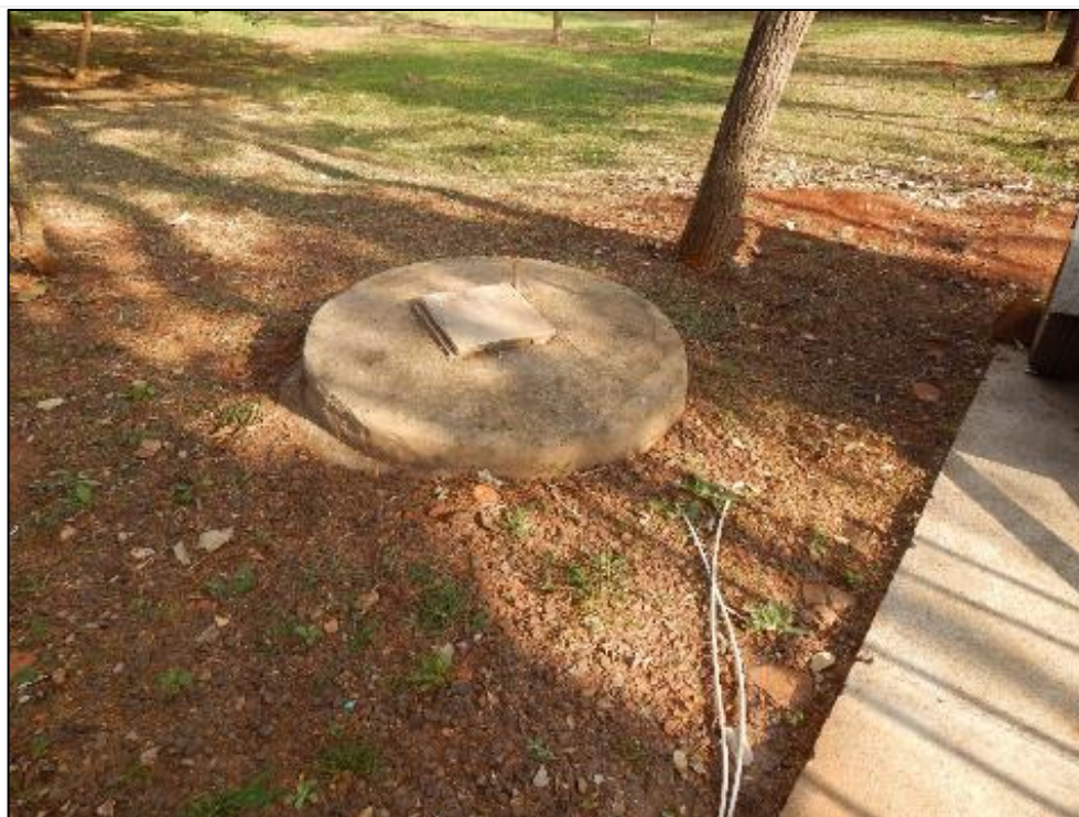
Figura LXXXII – Fossa Séptica no condomínio Cantinho do Lazer
