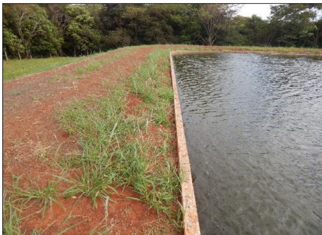
Figura LXXIII – Guia construída ao redor das lagoas
