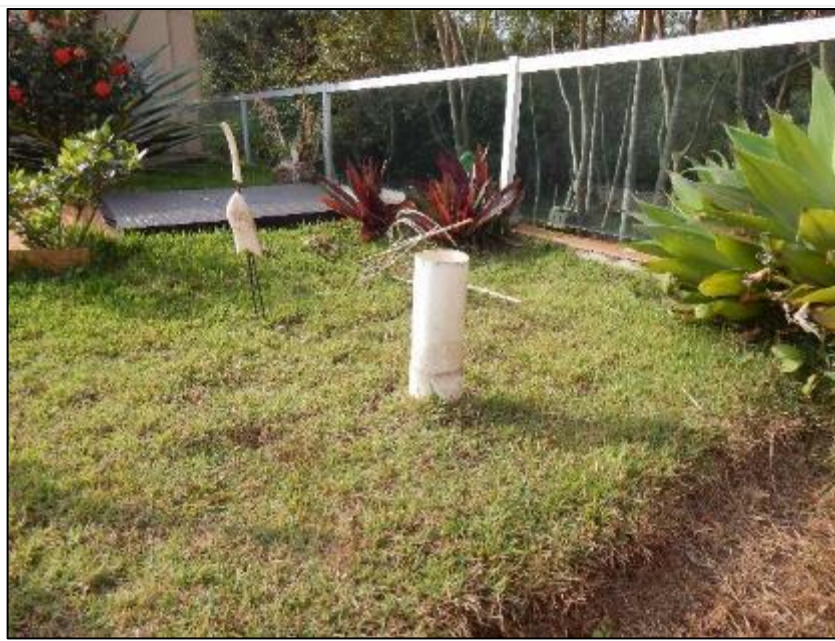
Figura LXXXV – Fossa Séptica no condomínio Recanto das Águas
