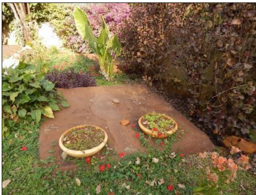
Figura LXXXIII – Fossas Sépticas revestidas no condomínio Cantinho do Lazer
