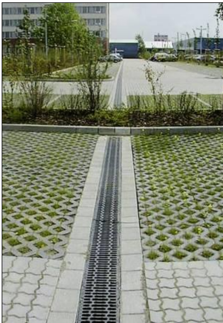
Figura CXXX – Aplicação de trincheira de infiltração em passeios
