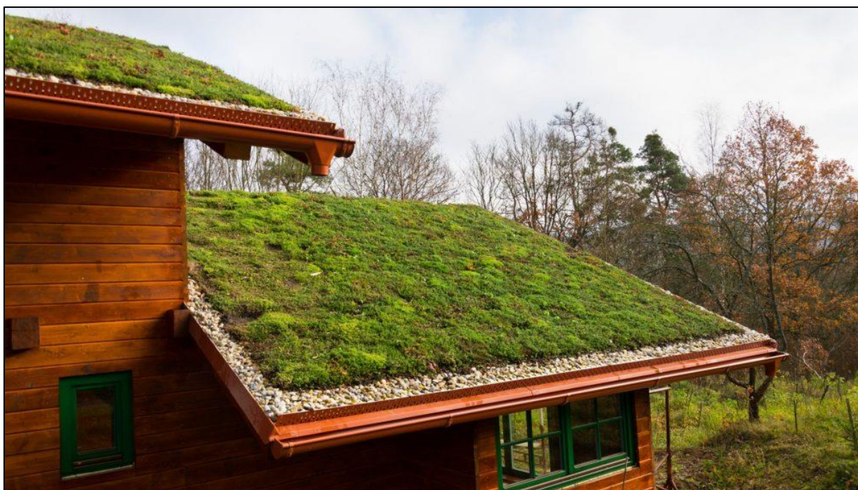
Figura CXXVIII – Exemplo de aplicação de telhado verde em residência
