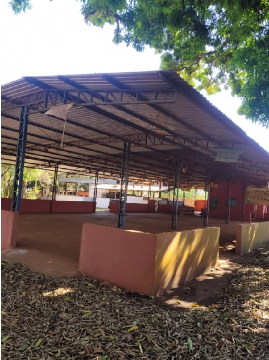
Tipo da imagem: Foto do Prédio
