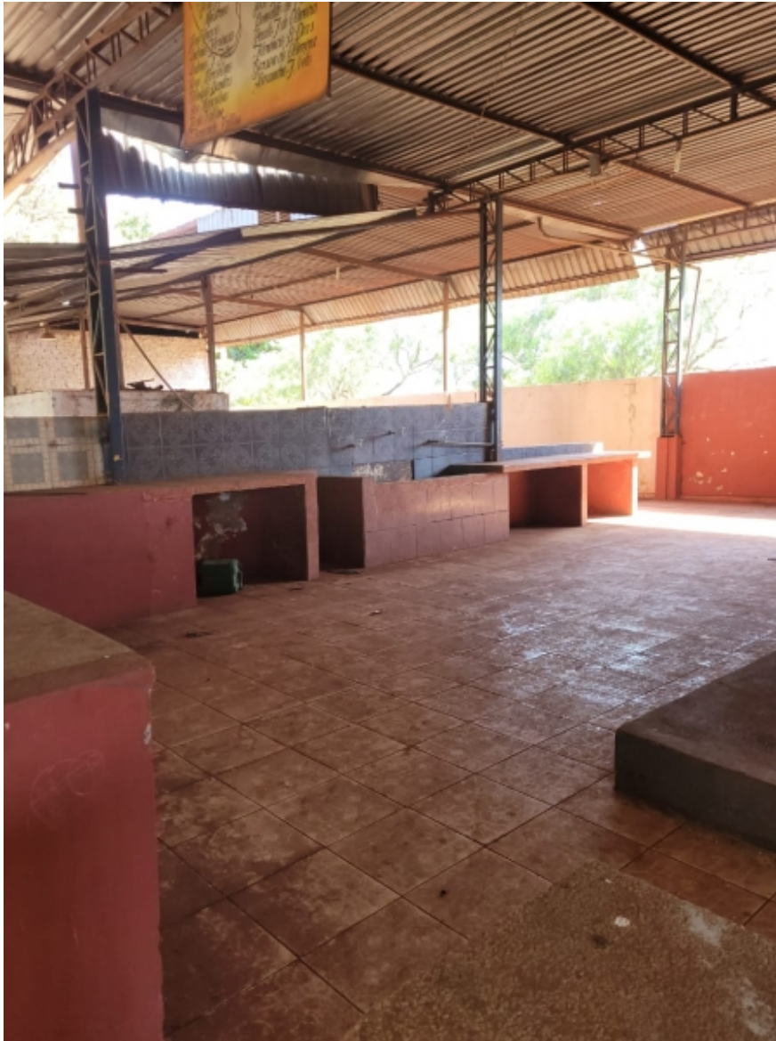
Tipo da imagem: Foto do Prédio
